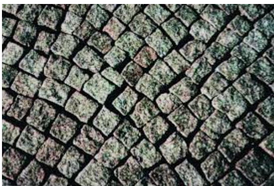
NAWIERZCHNIA Z KOSTKI NAWIERZCHNI ZJAZDÓW
